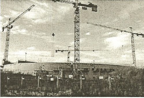
Les archéologues ont prévu de traiter 33 000 m 3 de déblais en cinq mois sur l'emprise des espaces extérieurs du Zénith. (Photo DNA - Laurent Réa)
