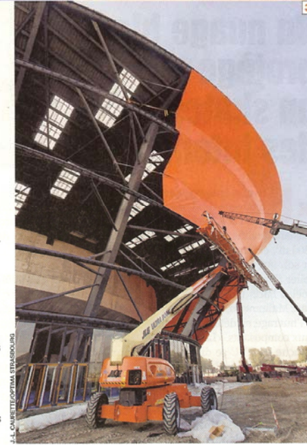
1 Longues de 440 m, les cerces de toile sont soutenues par 420 bracons arrimés à la charpente.
