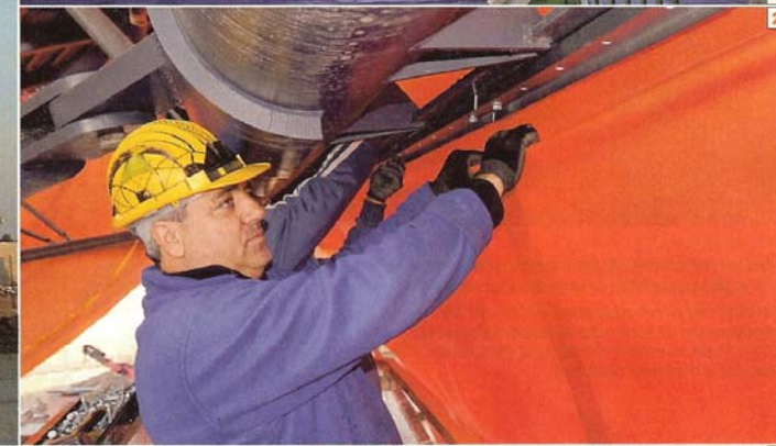
1 Longues de 440 m, les cerces de toile sont soutenues par 420 bracons arrimés à la charpente.
